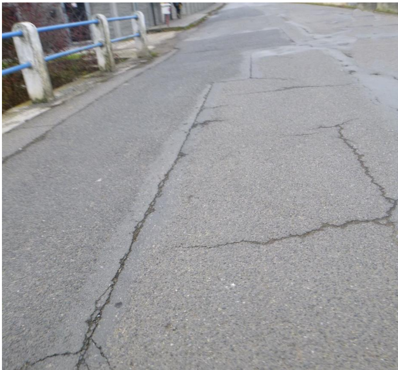
Trhliny ve vozovce
