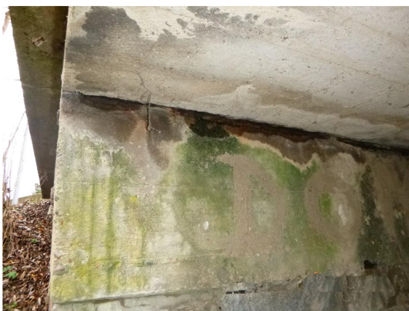
Degradace úložného prahu
